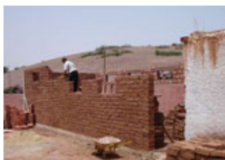
Figure 14 : Clapier moderne en pisé en cours de construction à l'ITA de Khénifra
