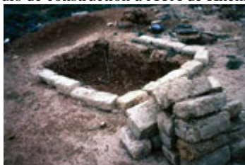
Figure 17 : Matmora en construction - région de Khémisset
