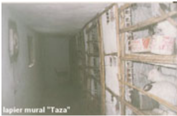
Figure 19 : Clapier mural en maçonnerie dans un bâtiment - région de Taza
